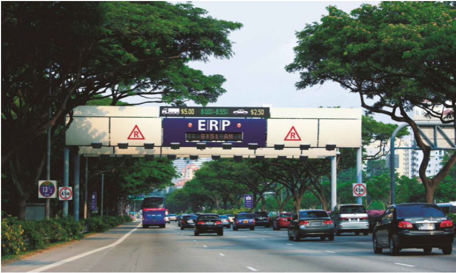
图 5-10 新加坡电子道路收费系统
